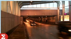
КУТУЗОВСКИЙ ТОННЕЛЬ АСУ ТП РЕАЛИЗАЦИЯ НА БАЗЕ ИСБ РУБЕЖ
